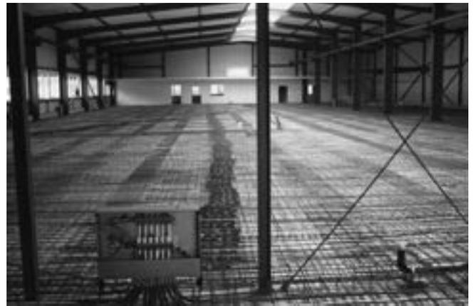
Als Pufferspeicher – hier im Bau – dient die Bodenplatte der Produktionshalle.
