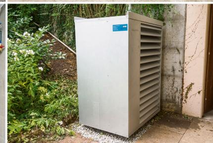
In Stetten wurde die alte Elektroheizung (oben links) durch eine Luftwärmepumpe ersetzt (unten links), die ausserhalb des Kellers Wärme aus der Luft zieht (unten rechts) und damit heizt. Auch die alten Leitungen (oben rechts) wurden rechtmässig isoliert. Bilder: Ramona Pfund
